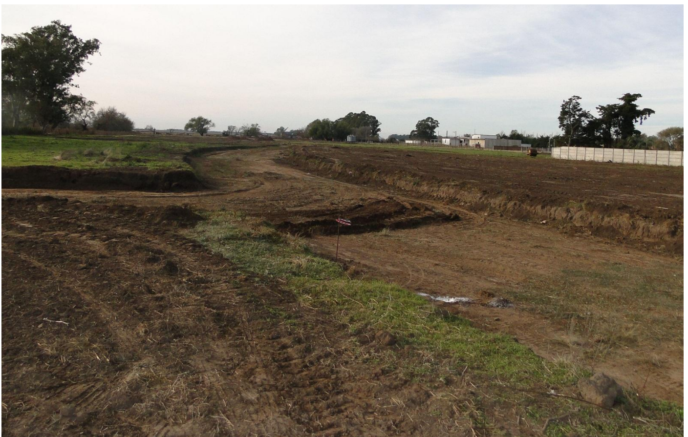
Figura 2 – Movimiento de suelos – Apertura de calles
