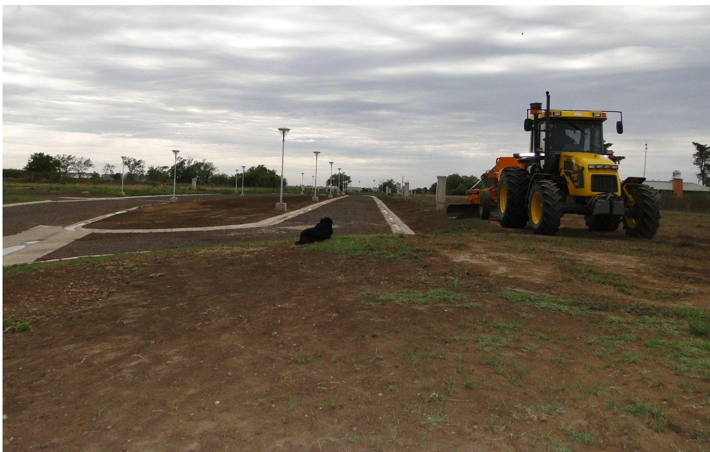
Figura 4 – Mantenimiento – Preparación para parquización
