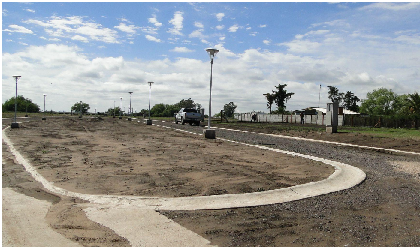
Figura 3 – Cordón cuneta, badenes y alumbrado público
