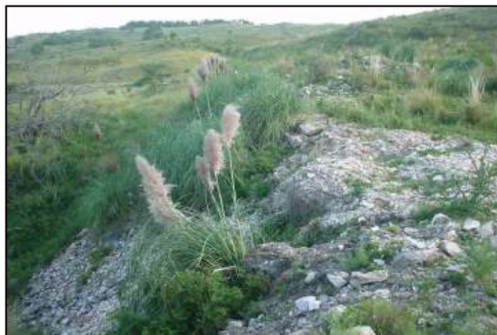
Escombrera con diseño en vaguada - revegetada
