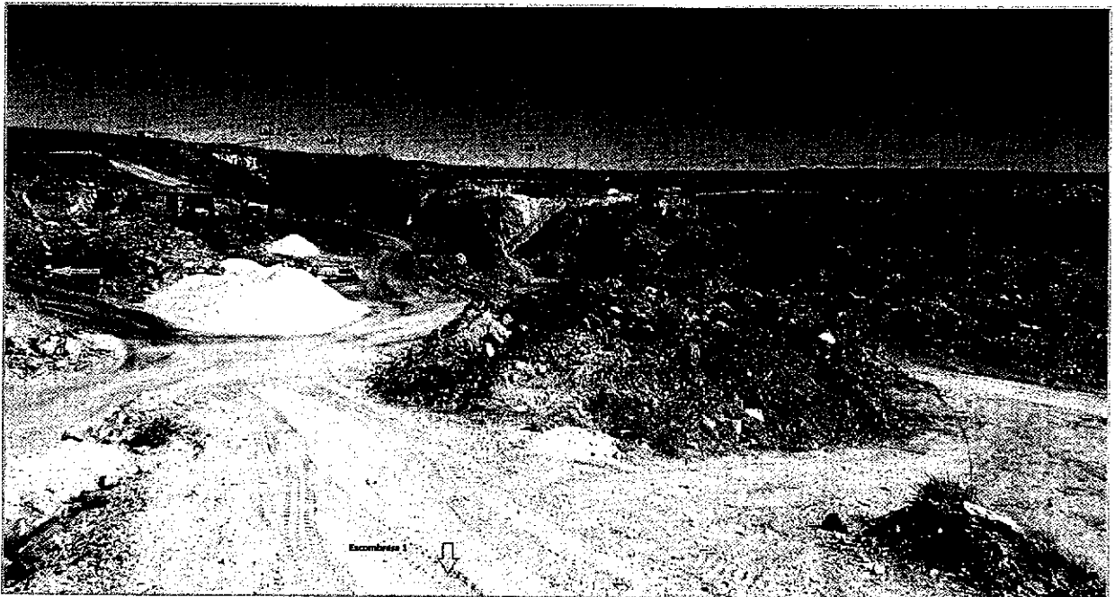
Foto N° 7. Localización de las distintas labores.
