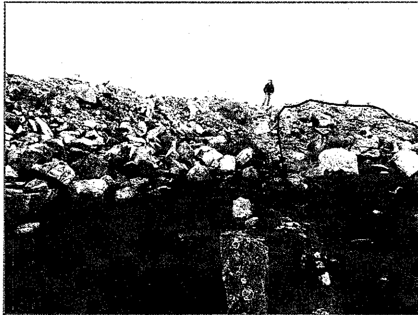
El sector demarcado es el que puede ser removido para facilitar el pasaje de agua en las épocas de crecidas.
