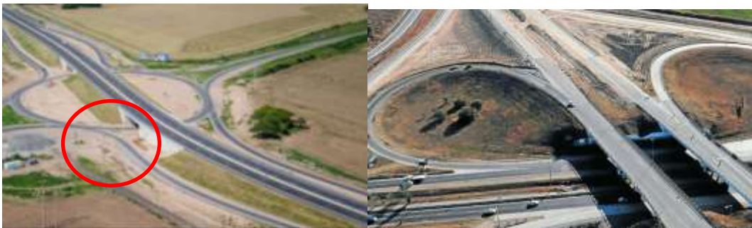
Imágenes de terraplenes de ascenso
