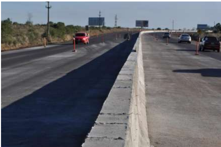
Imagen tramo II del proyecto vial “autovía Ruta Nacional N° 12”.
