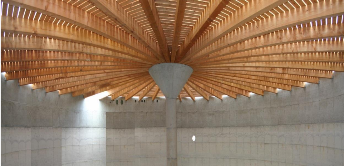
Estructura de madera
