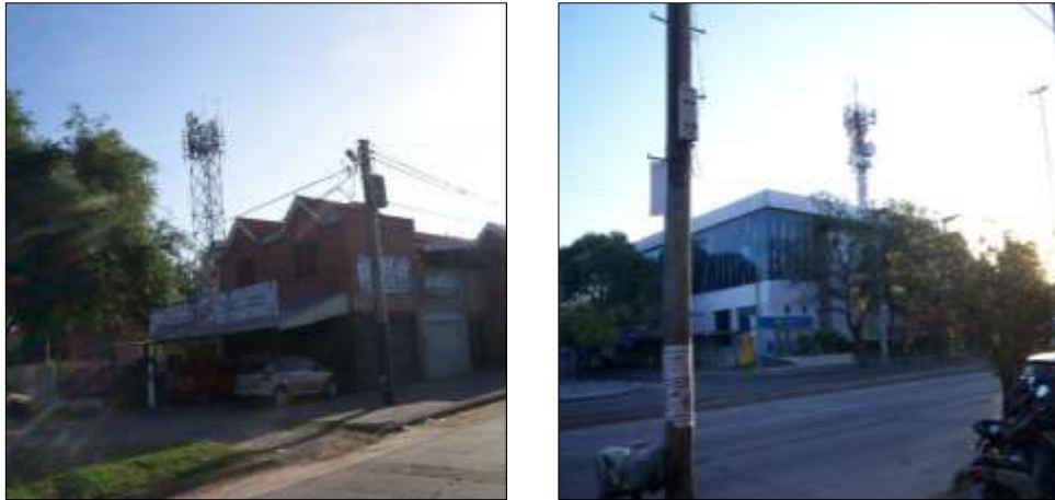
Fig. 8- Vista de las estructuras identificadas como Antenas N°3 y N°4
