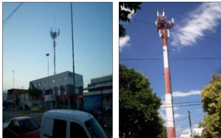
Fig. 9- Vista de las estructuras identificadas como Antenas N°5 y N°6
