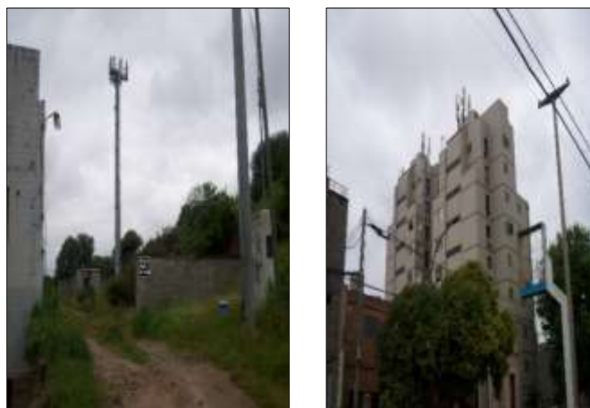
Fig. 11- Vista de las estructuras identificadas como Antenas N°9 y N°10
