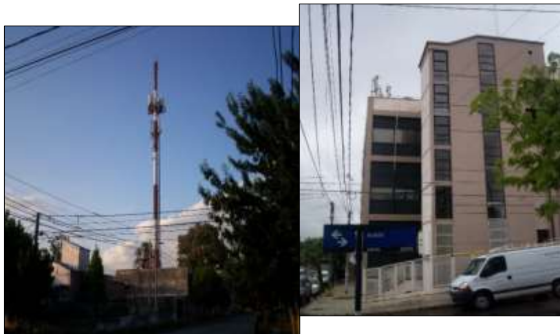
Fig. 10- Vista de las estructuras identificadas como Antenas N°7, N°8.
