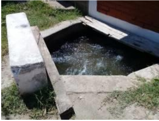
Fotografía 5: Prog. 120,00 acequia de riego Cruce según DETALLE C de plano DC: 05495/778
