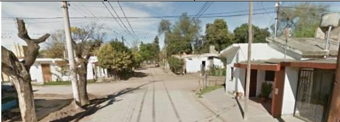
Fotografía 4: Prog. 78,00 esquina Duarte Quiroz y Sarmiento Vista N-S – termina pavimento articulado
