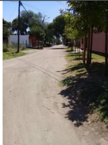
Fotografía 6: Prog. 180,00 Vista S-N de calle Duarte Quiroz Sin pavimento ni cordón cuneta
