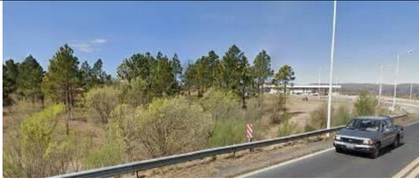
Fotografía 2: Vista puente elevado sobre vías FFCC
