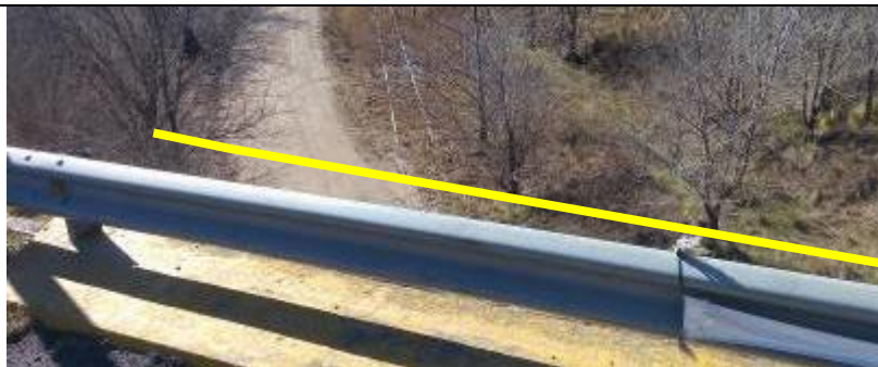
Fotografía 1: Vista de la zona de cruce de vías del FFCC (entre progresivas 17,50 y 41,70)
