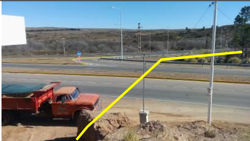
Fotografía 4: Vista general desde la Estación de servicio (desde progresiva 160 aproximadamente) Zona de cruce por tunnel
