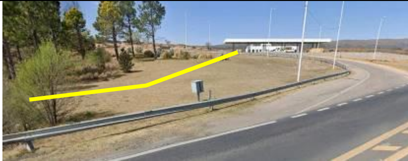
Fotografía 3: Vista general en sentido creciente hasta la Estación de Servicio – No afecta arbolado
