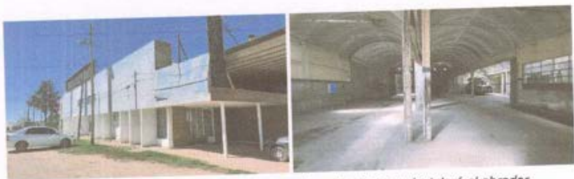
Figura 2: Instalaciones existentes en el predio donde se instalará el obrador.
