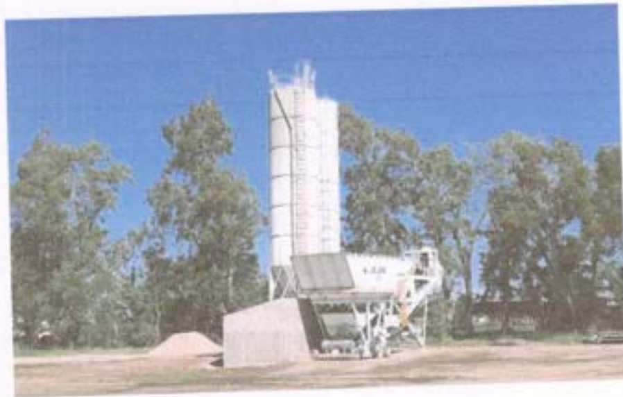
Figura 9: Planta de hormigón de Luciano S.A.
