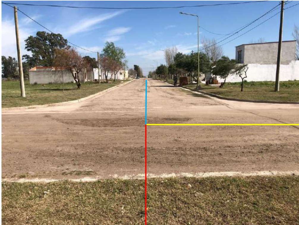
Fotografía 8. Vista hacia el oeste, en la esquina de calle 20 y 21, se realizará la conexión del nuevo ramal (amarillo) con el ramal existente (celeste). La línea de color rojo muestra el tramo a desafectar.
