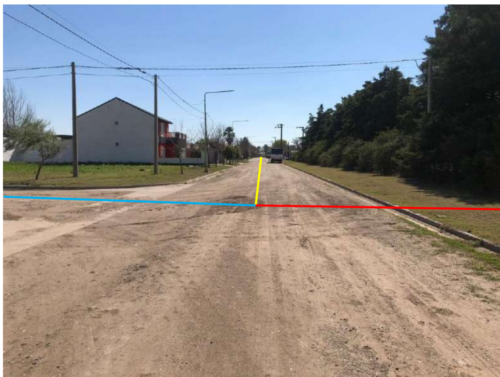
Fotografía 7. Vista hacia el norte, en calle 21, donde se realizará la conexión del nuevo ramal (amarillo) con el ramal existente (celeste). La línea de color rojo muestra el tramo a desafectar.
