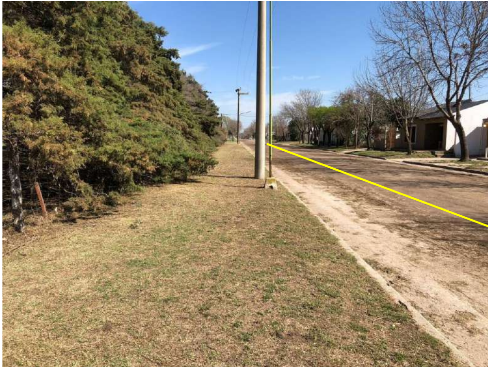
Fotografía 6. Vista de la traza donde se instalará el nuevo ramal de alimentación de 102 mm sobre calle 18 en la localidad de Chazón.
