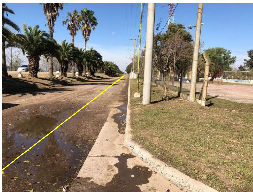
Fotografía 3. Vista de la traza donde se instalará el nuevo ramal de alimentación de 102 mm sobre calle interna paralela a Ruta Provincial N°4.
