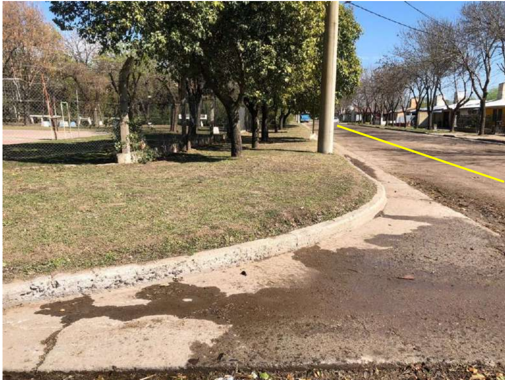
Fotografía 4. Vista de la traza donde se instalará el nuevo ramal de alimentación de 102 mm sobre calle 18 en la localidad de Chazón.
