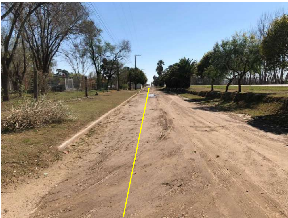
Fotografía 2. Vista de la traza donde se instalará el nuevo ramal de alimentación de 102 mm sobre calle interna paralela a Ruta Provincial N°4.
