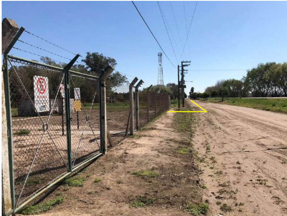
Fotografía 1. Vista de la traza donde se instalará el nuevo ramal de alimentación de 102 mm en la entrada a la PRI Chazón.
