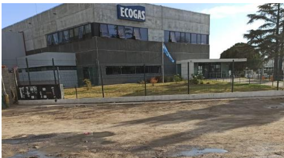
Imagen 7: Planta Distribuidora de Gas del Centro
