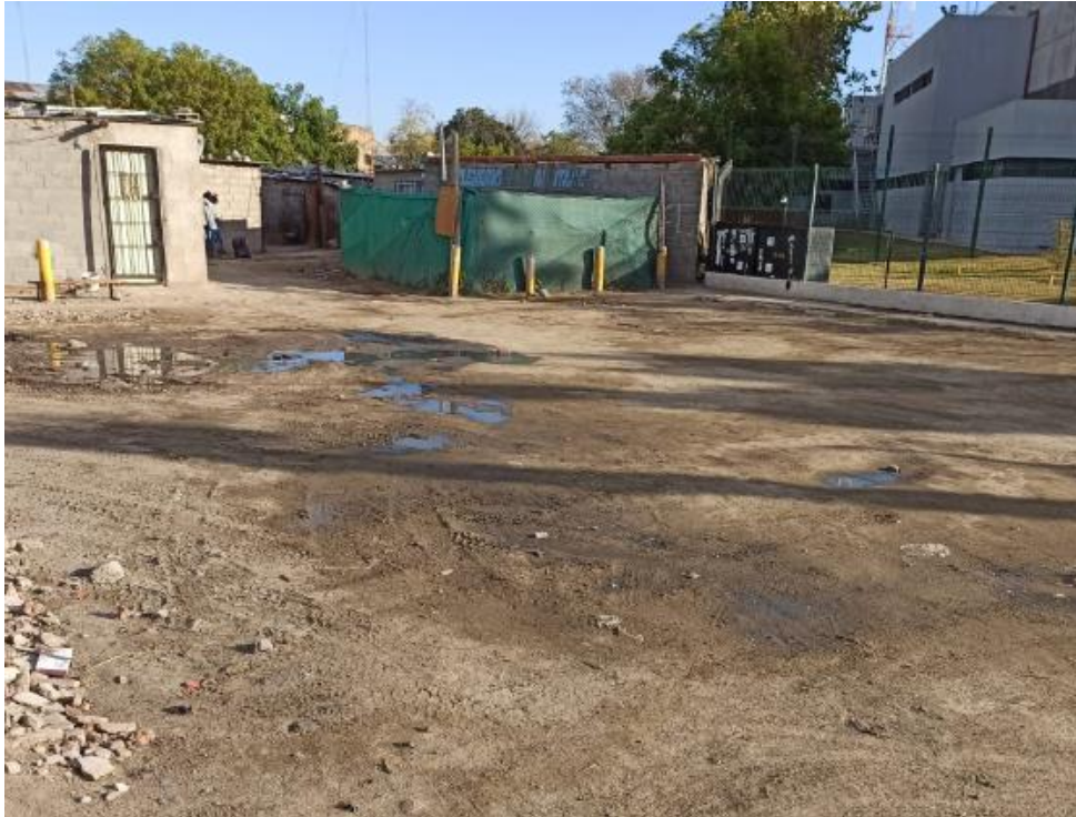
Imagen 8: Sector de ramal existente afectado por viviendas contiguas a la planta
