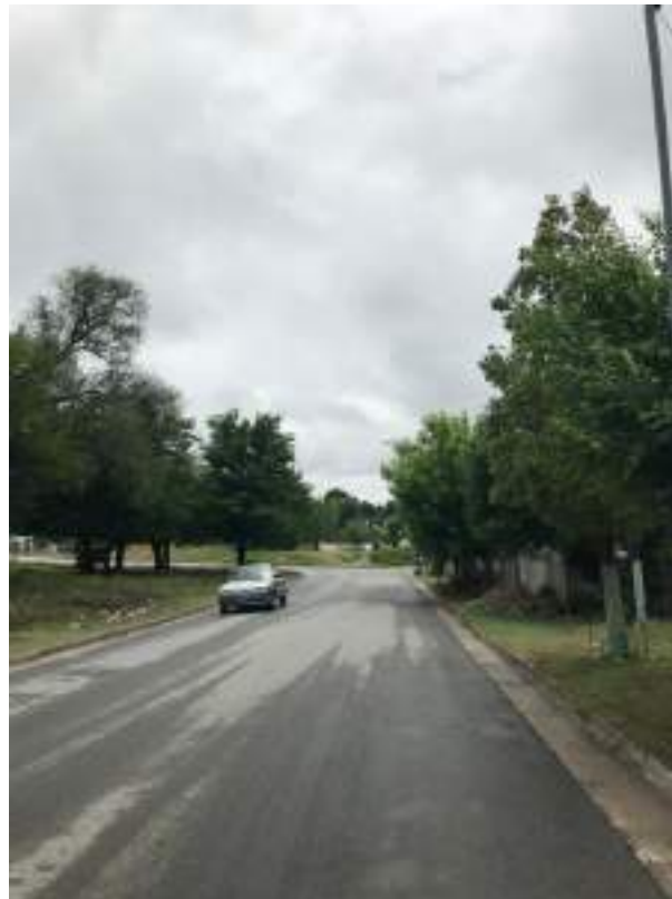
Ilustración 4. Vista desde calle San Jerónimo, la misma se encuentra asfaltada y con cordón cuneta.
