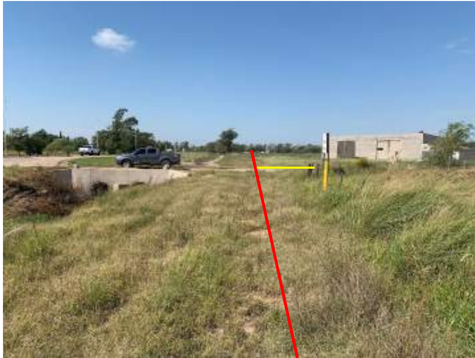
Fotografía 1. Vista del tramo de conexión, entre el canal y la línea de campo privado. La traza de color rojo indica el gasoducto de 152mm y la línea de color amarilla el Ramal de Alimentación de 51mm (23kg/cm 2 ). Foto Tomada el 25/11/2022.
