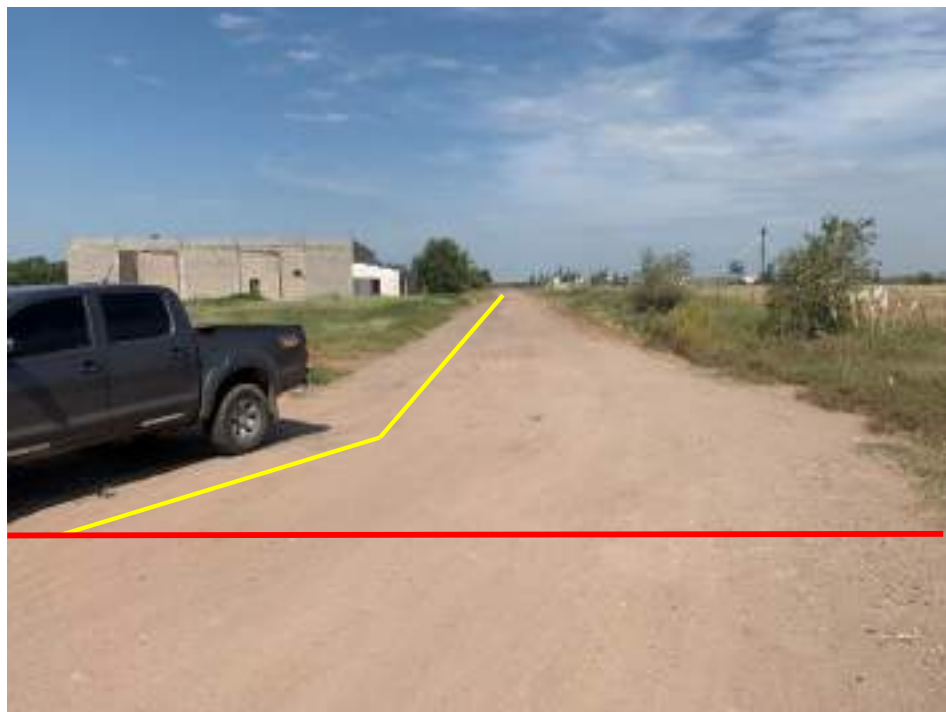
Fotografía 2. Vista del tramo de conexión sobre calle Pública. La traza de color rojo indica el gasoducto de 152mm y la línea de color amarilla el Ramal de Alimentación de 51mm (23kg/cm 2 ). Foto Tomada el 25/11/2022.
