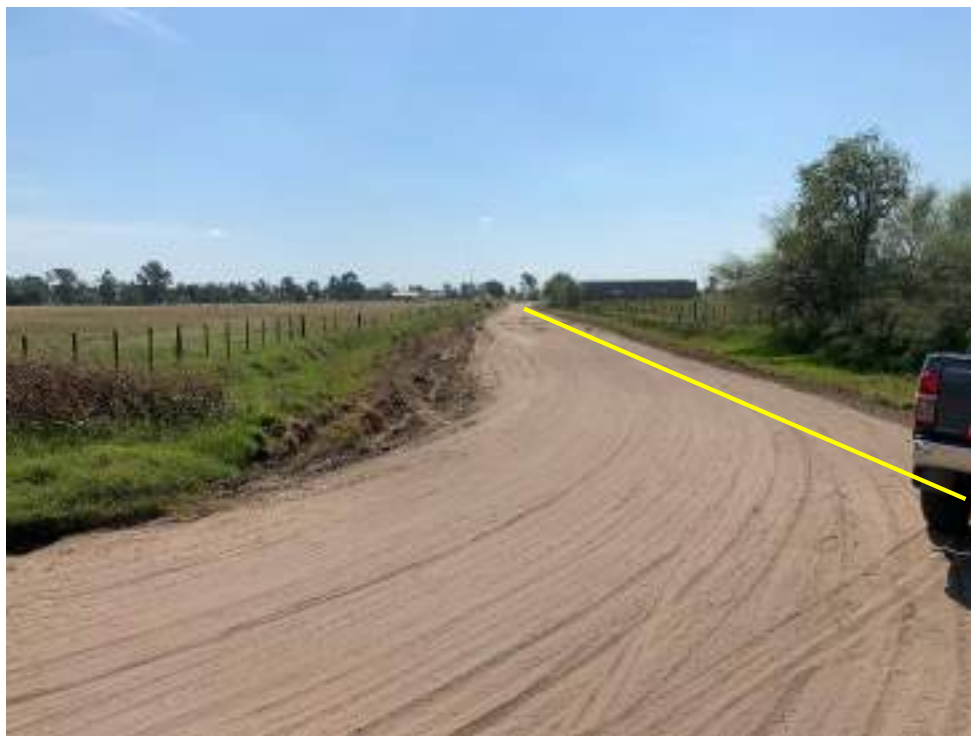
Fotografía 3. Vista del tramo donde se realizará la instalación del Ramal de Alimentación 23 kg/cm 2 , sobre calleo Pública. Foto Tomada el 25/11/2022.
