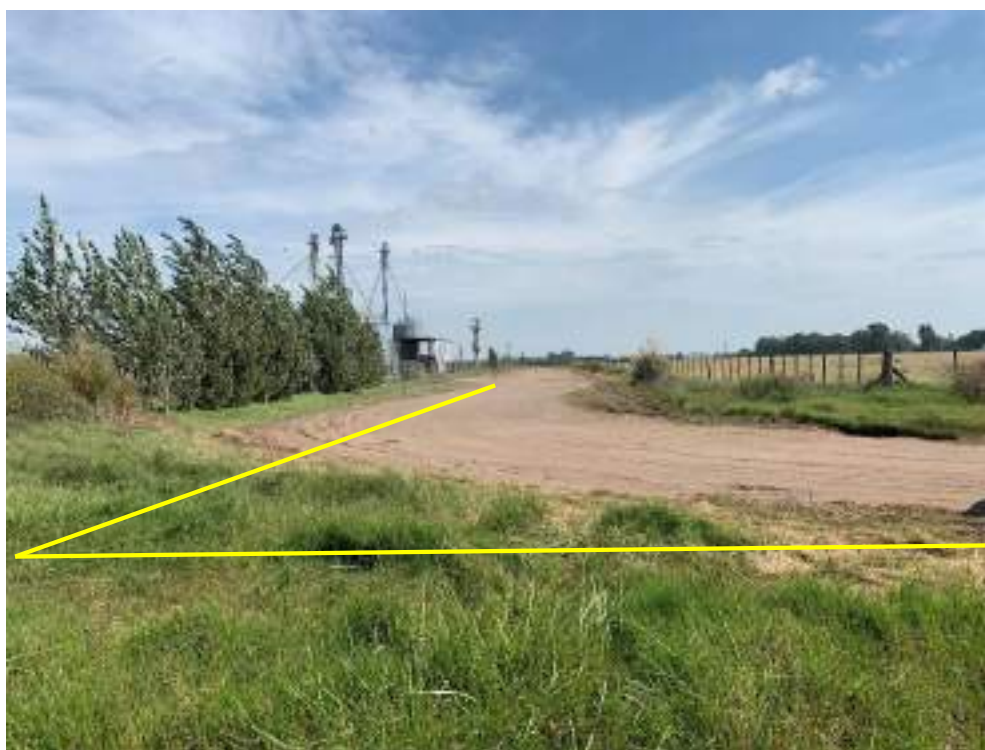
Fotografía 4. Vista del tramo donde se realizará la instalación del Ramal de Alimentación 23 kg/cm 2 , sobre calleo Pública. Foto Tomada el 25/11/2022.
