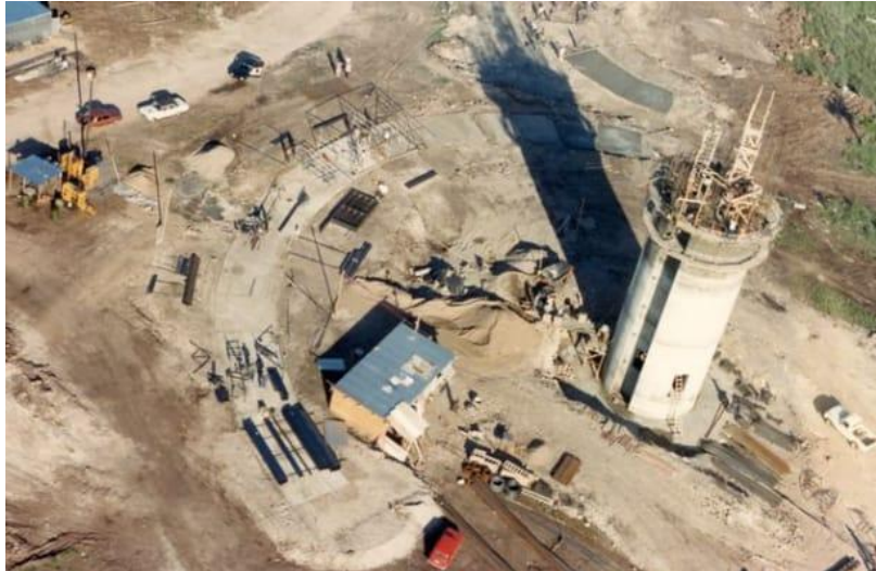
Figura N° 2: Imágenes del momento de construcción.
