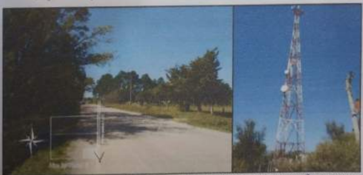
Imagen N°8. Fotografías de la cortina forestal vista desde el camino S-222 (izquierda) y de la antena de telefonía (derecha).
