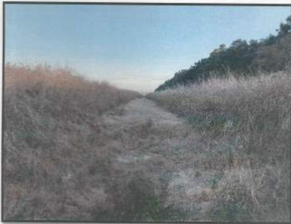
Figura 44: Vista hacia aguas debajo de cuneta R.P. N° 13.
