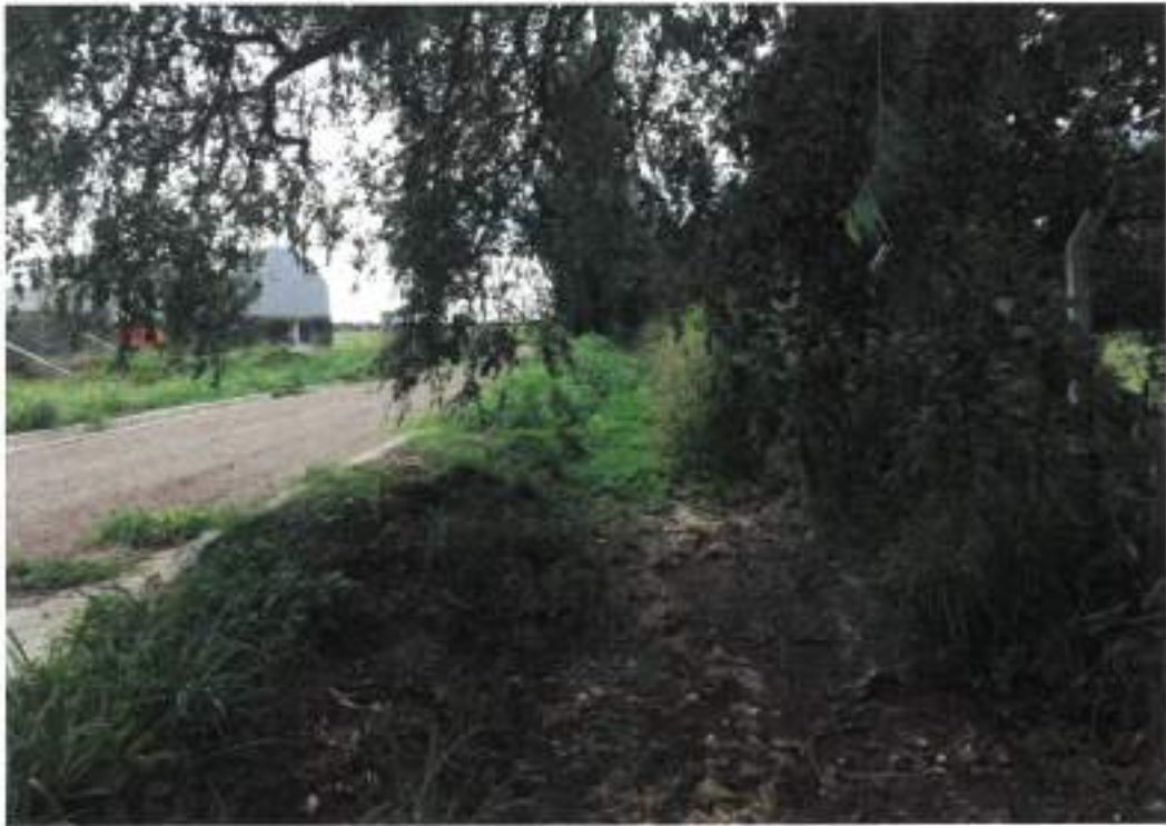
Imagen 2: Vista hacia aguas abajo del canal
