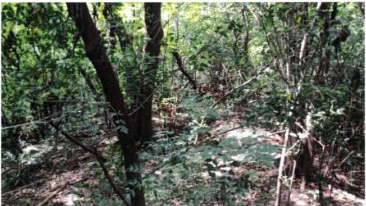
Imagen 7: Canalizaciones fuera de servicio, Retenciones existentes de la cuenca despreciadas en el cálculo. Ver punto 3.6
