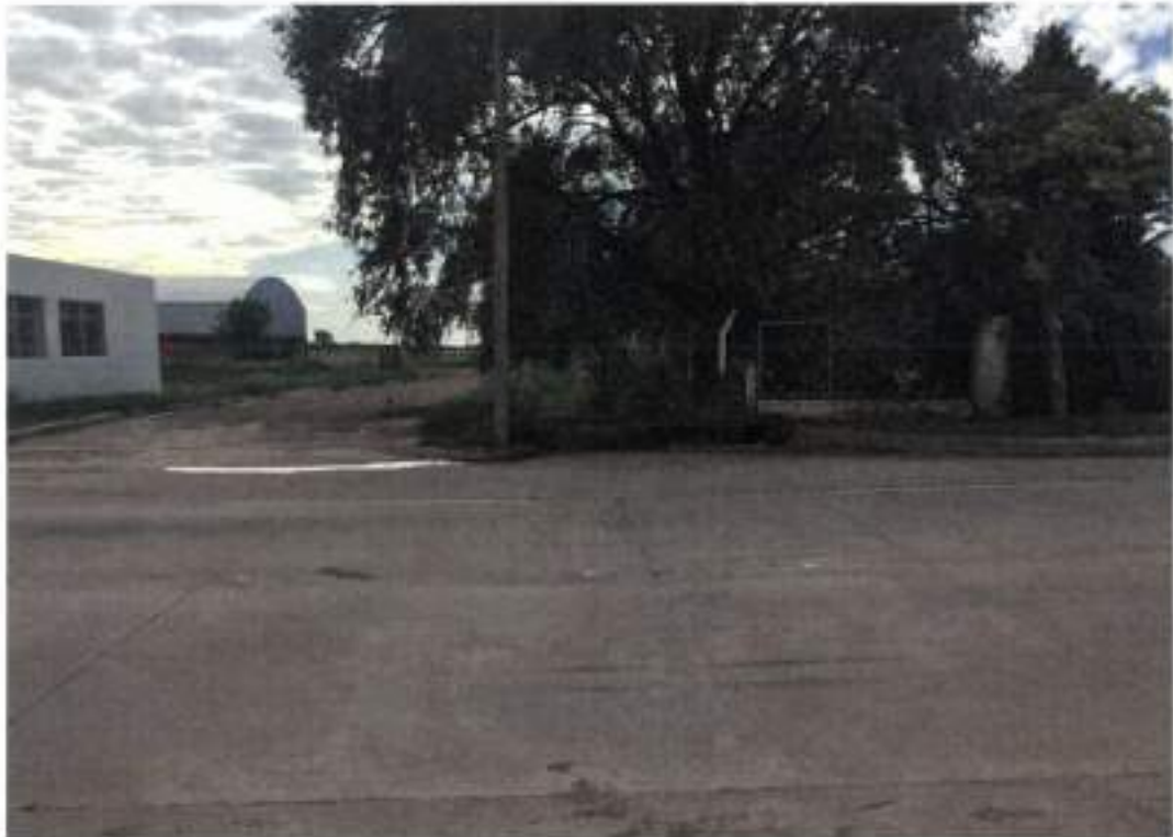
Imagen 1: Punto de Cierre de la cuenca. Ingreso canal ubicado en Ruta A74
