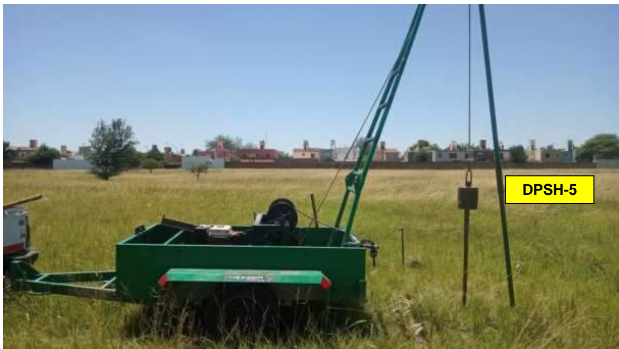
Foto 8 - Lugar de ubicación del sondeo dinámico DPSH-5 (23/12/2021).
