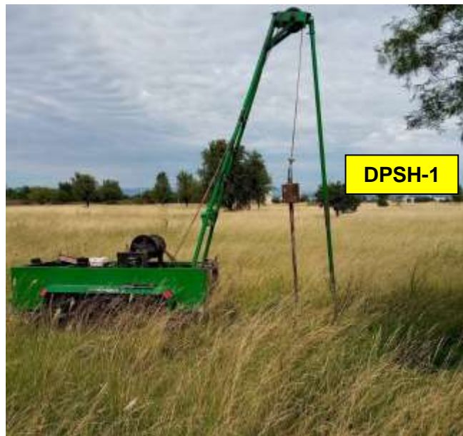
Foto 4 - Lugar de ubicación del sondeo dinámico DPSH-1, al momento de su ejecución (22/12/2021).
