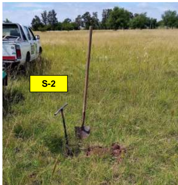
Foto 11 - Vista a boca del sondeo mecánico S-2 (22/12/2021).
