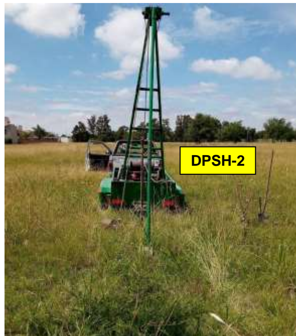
Foto 5 - Lugar de ubicación del sondeo dinámico DPSH-2 (22/12/2021).
