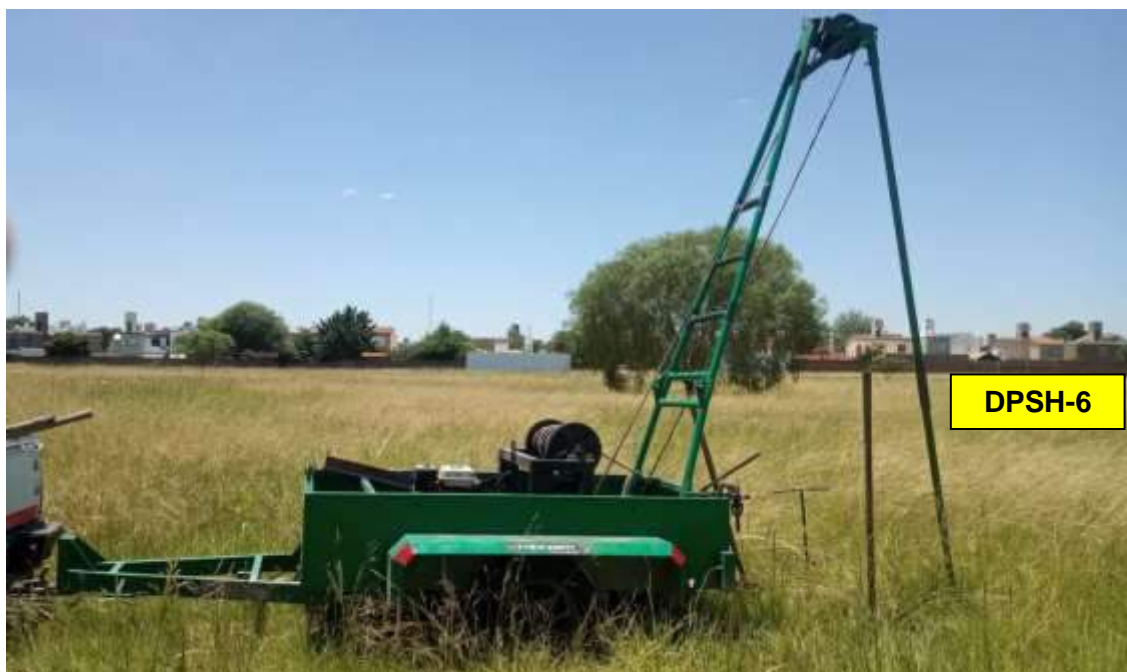
Foto 9 - Lugar de ubicación del sondeo dinámico DPSH-6 (23/12/2021).
