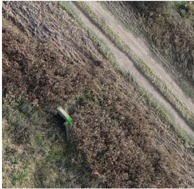
ALCANTARILLA CAMINO RURAL PARALELO A FFCC
