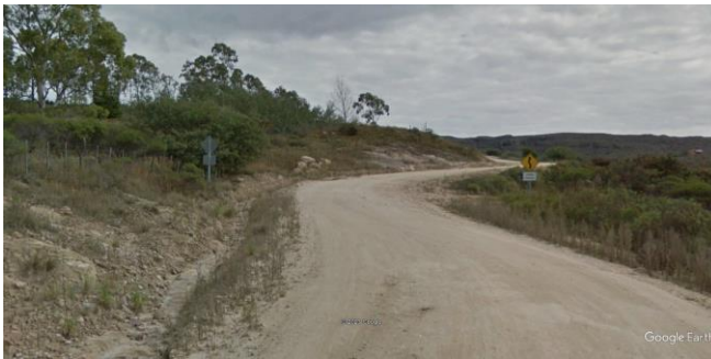
Figura 7. Inicio de tramo con perfil rural, Vista al NO
