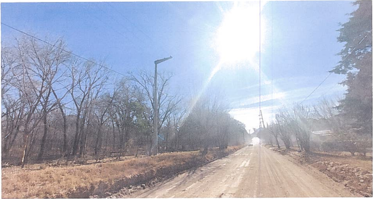
Figura 15. Situación actual del predio. Límite Este (a la izquierda). Foto hacia el Norte sobre Camino Provincial
