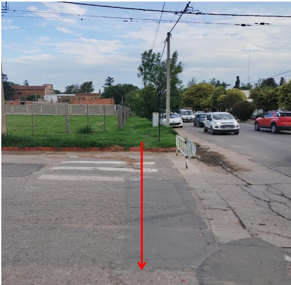
Imagen 8: Punto de Conexión a gasoducto existente
