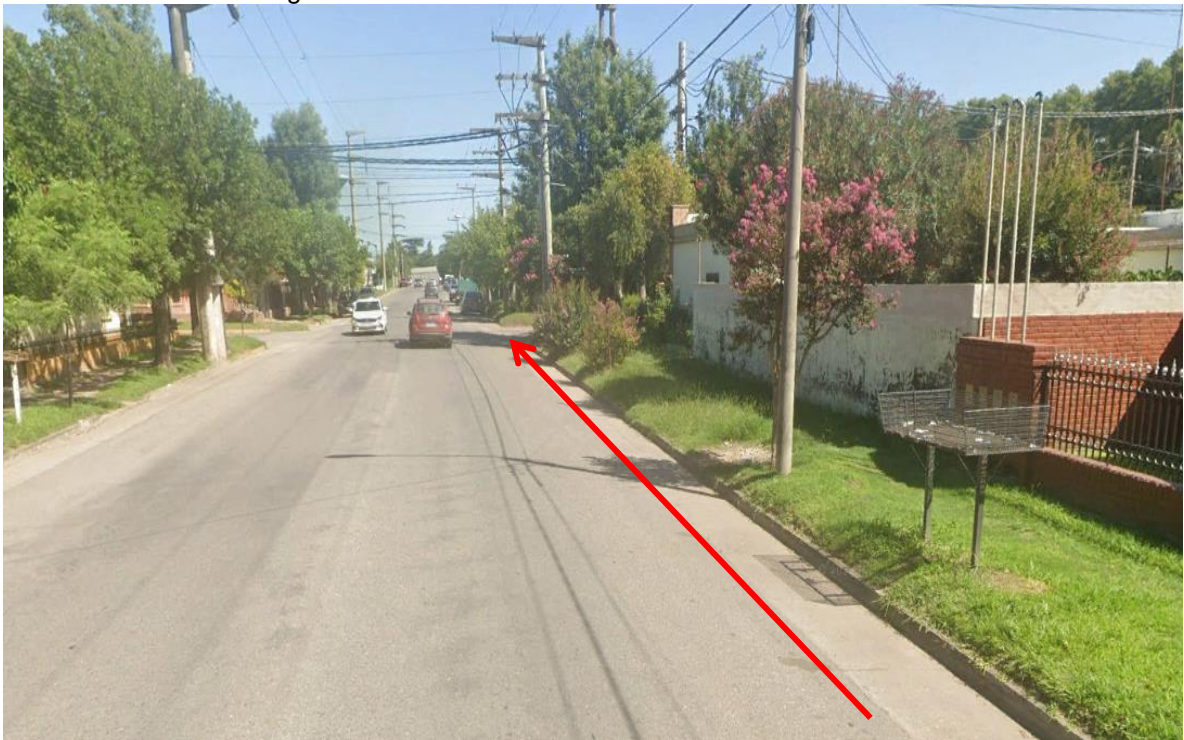
Imagen 12: Ramal de Alimentación en Calle Don Bosco
