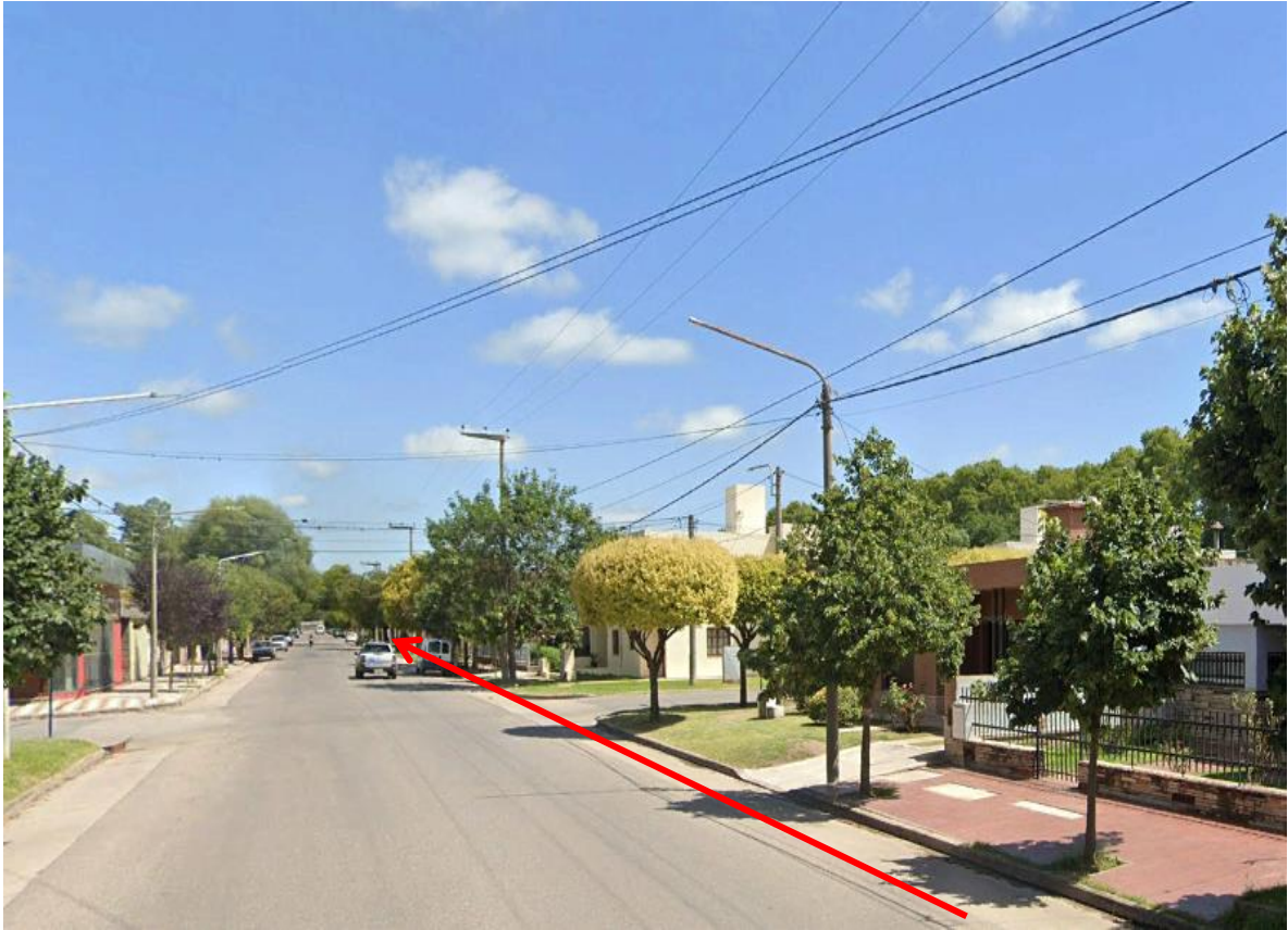
Imagen 11: Ramal de Alimentación en Calle Don Bosco
