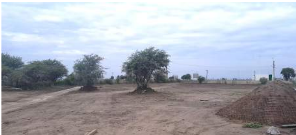
Fig 8: Trabajos de nivelación del terreno.-
