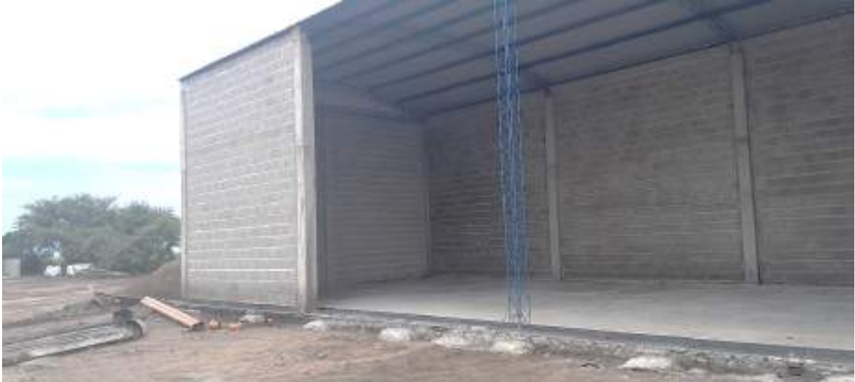
Fig 9: Galpones en construcción dentro del predio.-
