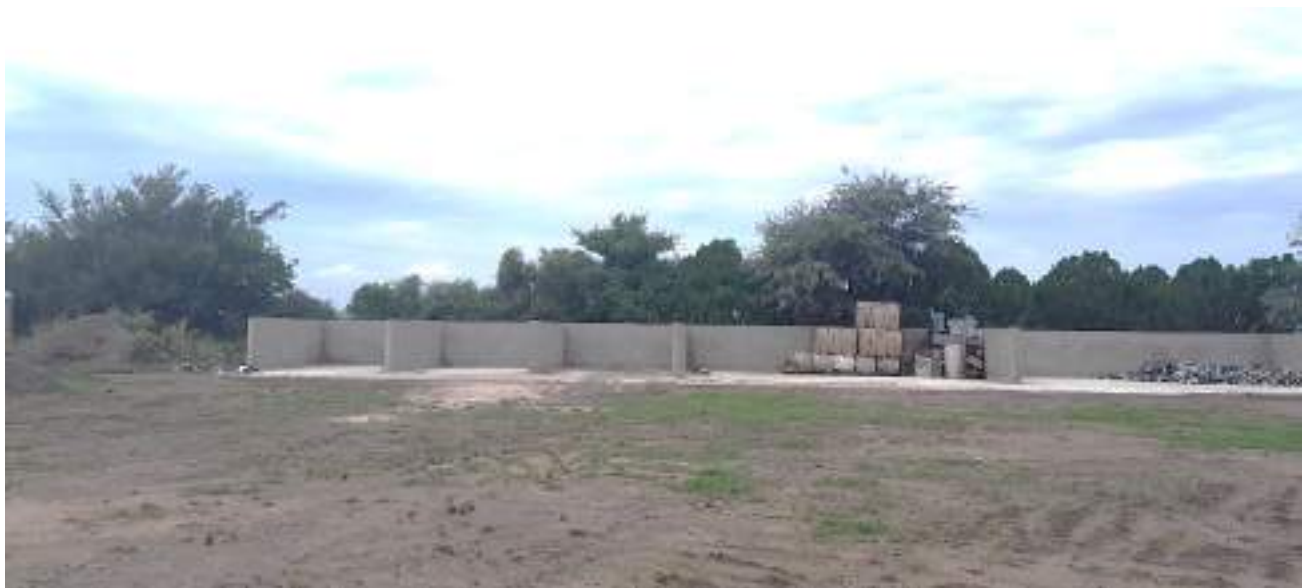
Fig 10: Boxes para el almacenamiento de fardos.-
