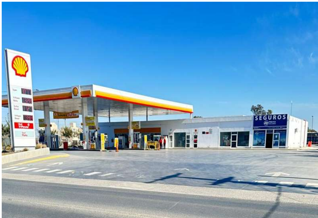
Imagen 21: Punto de Conexión a GNC ANJOR S.A.
