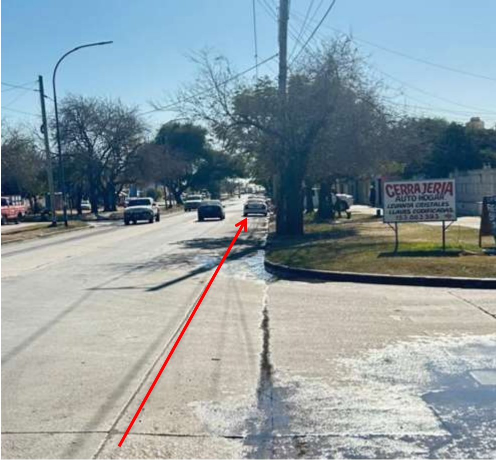
Imagen 14: Ramal de Interconexión
