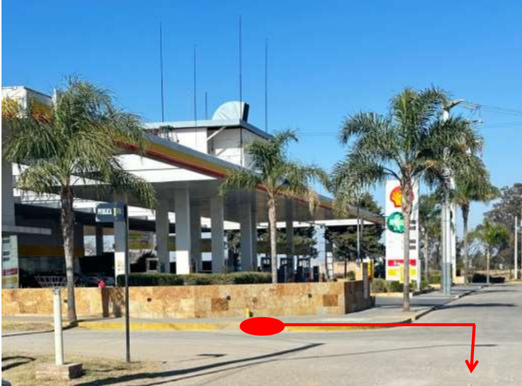
Imagen 16: Punto de Conexión Ramal de Alimentación a GNC ANJOR S.A.
