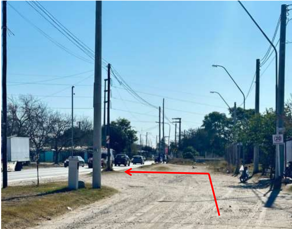
Imagen 18: Ramal de Alimentación a GNC ANJOR S.A.
