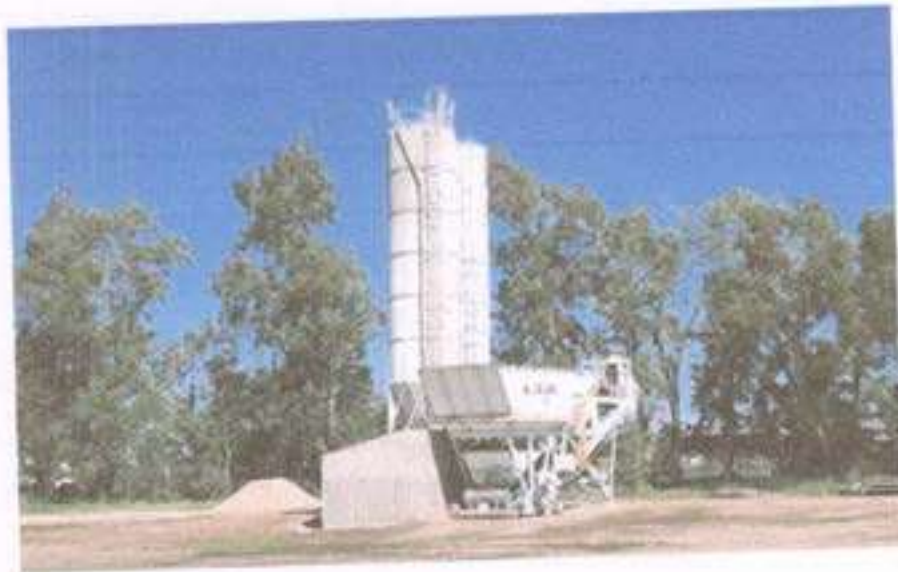
Figura 9: Planta de hormigón de Luciano S.A.
