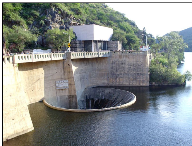
Fig. 13 - Vertedero del dique
