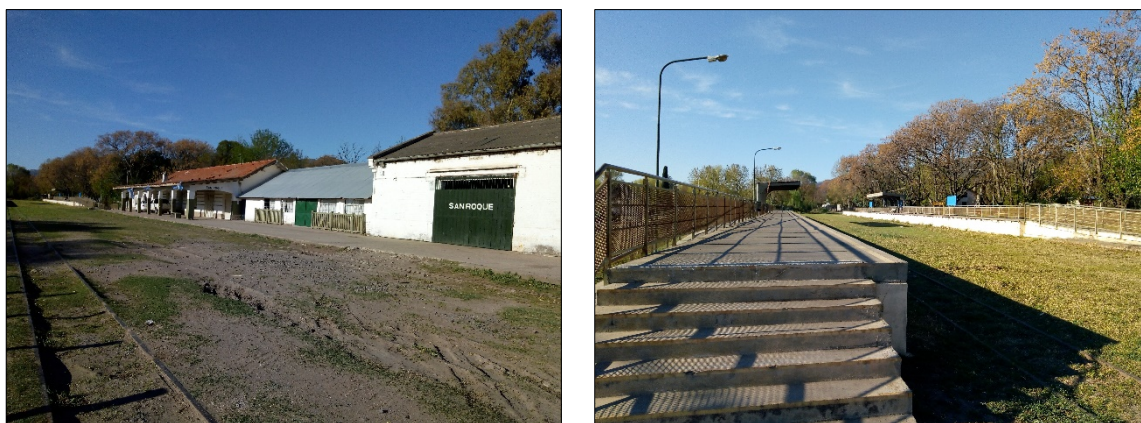
Fig. 14 - Vista Comuna y estación de trenes San Roque
