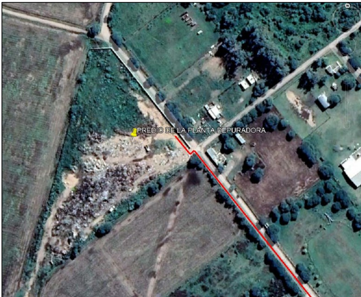
Ilustración 3 - Predio donde se ubicará la planta depuradora
