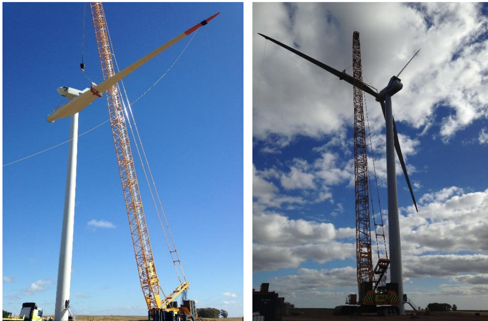
Imagen 5: Montaje de aerogeneradores
