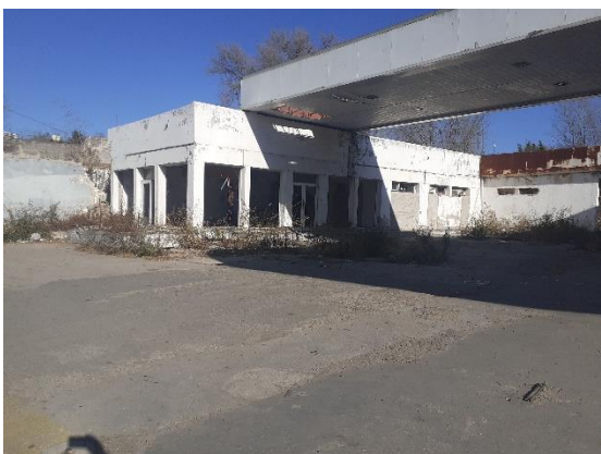
Fig. 1. Vista Sur Oeste del predio. (lateral Izq.) Actual
