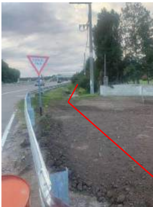
Fotografía 1. Vista del tramo de conexión con la Estación de GNC (traza de color rojo), en cruce de rotonda de RP E53. Foto Tomada el 25/07/2021.
