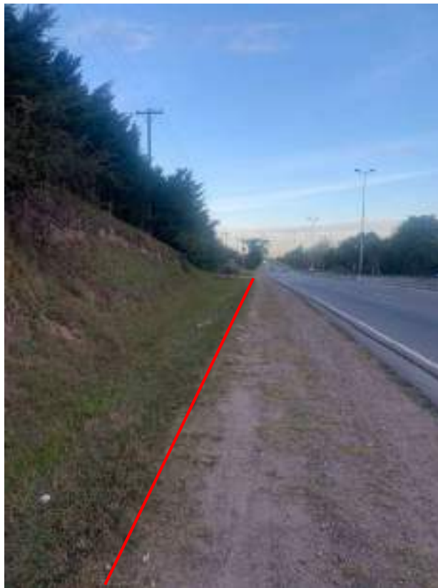
Fotografía 6. Vista del tramo donde se realizará la instalación del Ramal, en banquina de autovía E53 (traza de color rojo). Foto Tomada el 25/07/2021.
