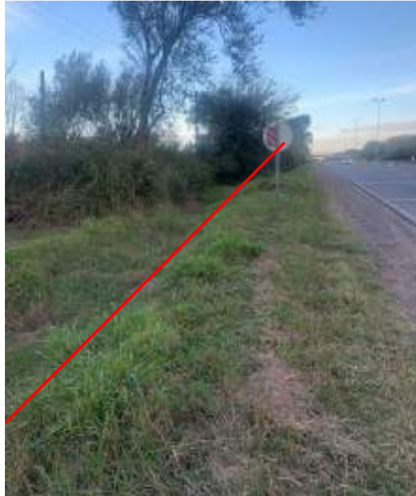
Fotografía 4. Vista del tramo donde se realizará la instalación del Ramal, hacia el norte del Cementerio Parque Catedral (traza de color rojo). Foto Tomada el 25/07/2021.
