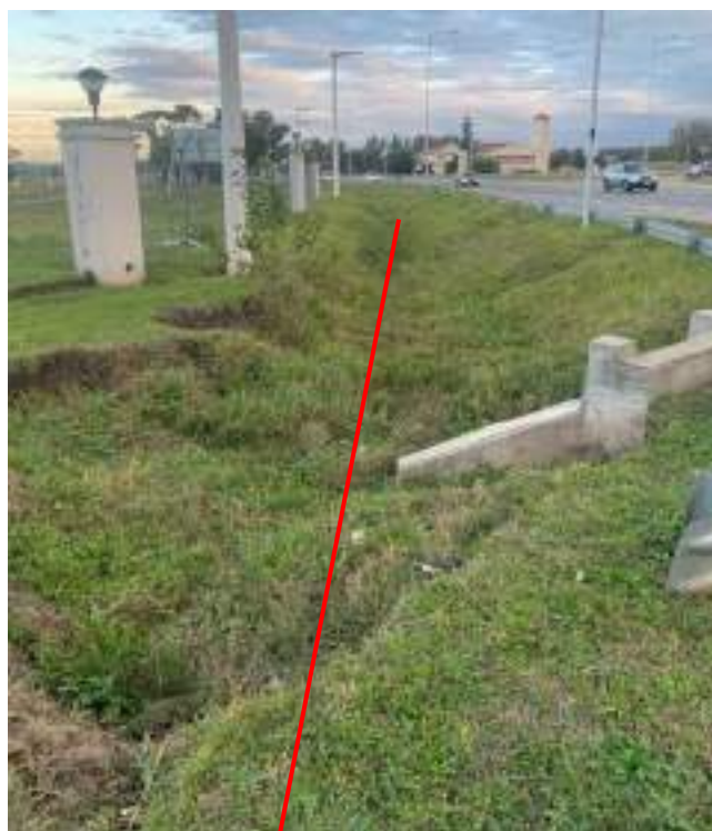
Fotografía 8. Vista del tramo donde se realizará la instalación del Ramal, en banquina de autovía E53 (traza de color rojo). Foto Tomada el 25/07/2021.
