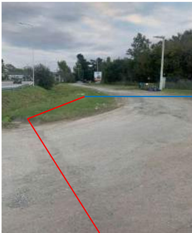
Fotografía 10. Vista del tramo de conexión al ramal de 152 mm existente (traza azul), en banquina de autovía E53. En rojo se muestra la futura traza donde se realizará la instalación del ramal. Foto Tomada el 25/07/2021.
