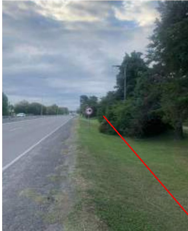
Fotografía 3. Vista del tramo donde se realizará la instalación del Ramal, en la zona del Cementerio Parque Catedral (traza de color rojo). Foto Tomada el 25/07/2021.
