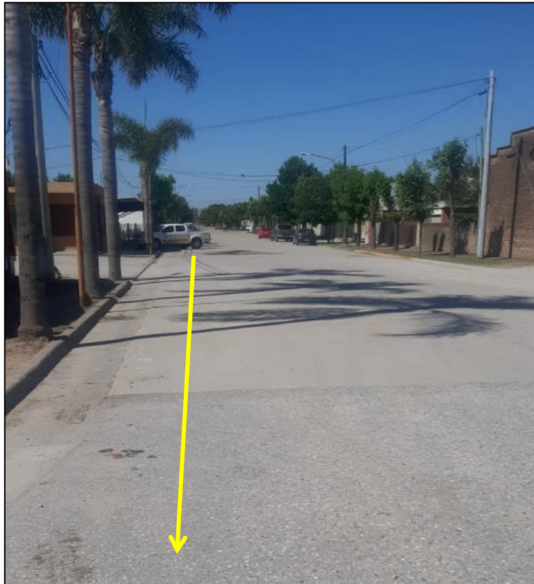
Imagen 10: Ramal de Alimentación – DC 05421/777
