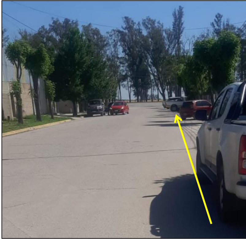
Imagen 11: Ramal de Alimentación – DC 05421/777
