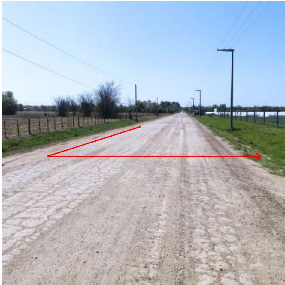
Imagen 9: Ramal de Alimentación Parque C.E.C.I.S.
