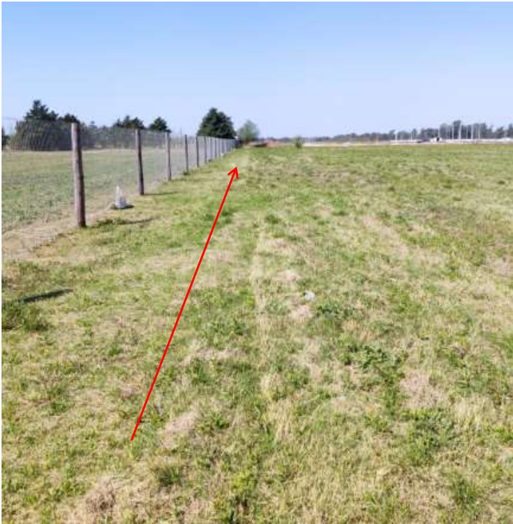
Imagen 10: Ramal de Alimentación Parque C.E.C.I.S.
