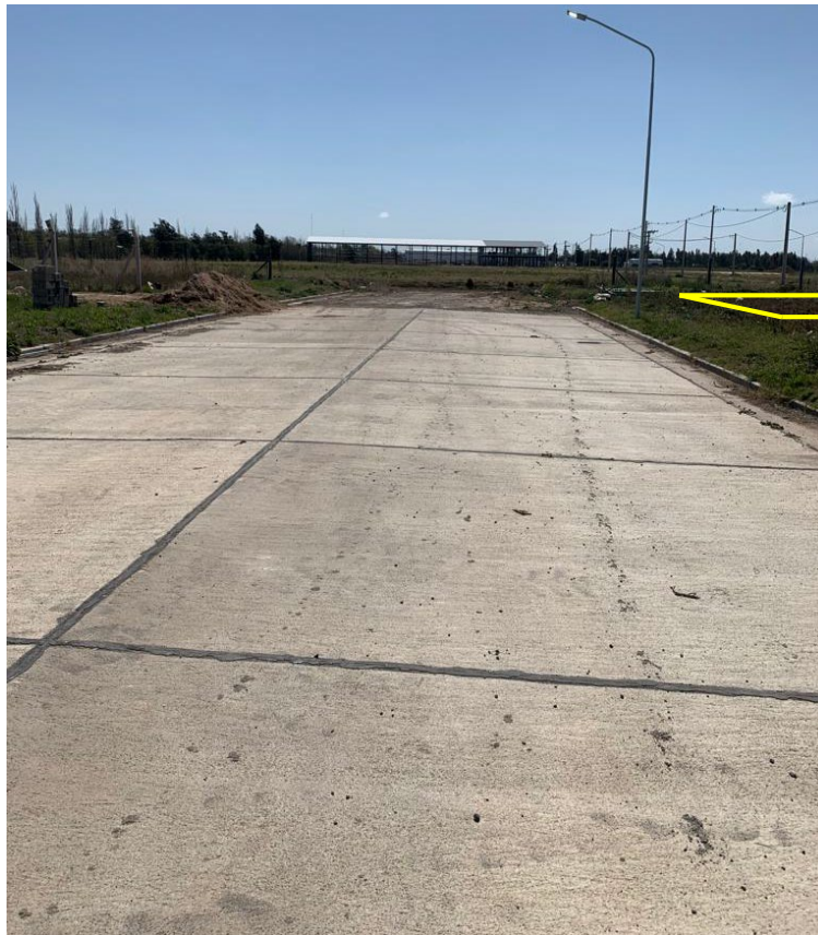
Fotografía 3. Vista hacia el norte del espacio verde donde se construirá la PRM (rectángulo amarillo) dentro del Parque Industrial C.E.C.I.S, Río Cuarto. Foto Tomada el 15/10/2024.
