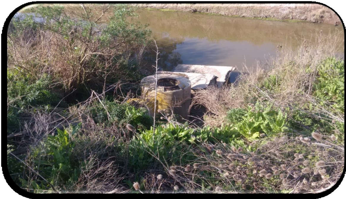
Ilustración 3 – Situación actual – Obra de descarga.
