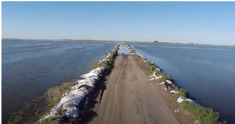
Figura n°2: Imagen de la RP N° 3, entre Ruta N° 8 y acceso a Bremen, inundada en 2016.
