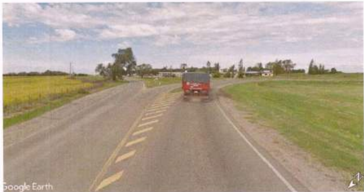
Figura 2.9 Vista de RN N°36 en inmediaciones de la intersección con RN N°8 (también se observa la rama de ingreso a RN N°36 desde camil ascendente de RN N°8).
