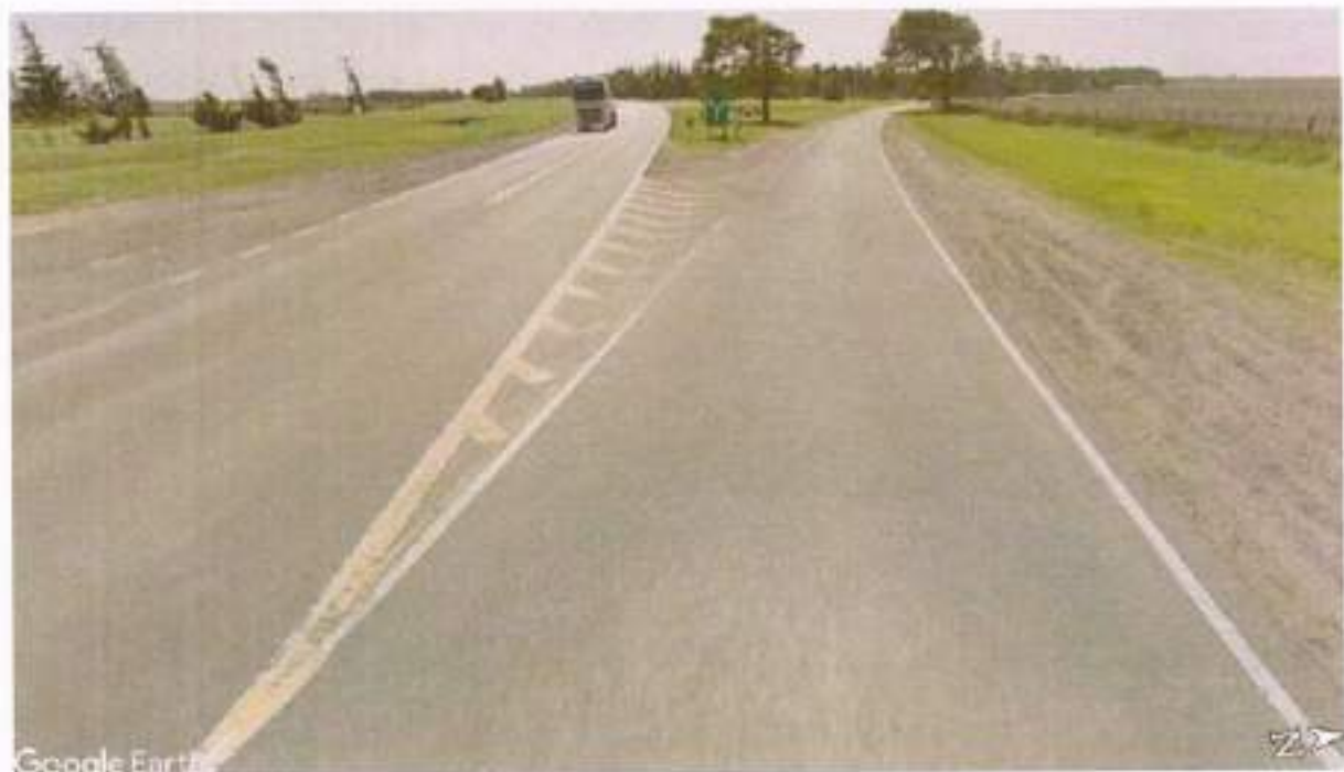
Figura 2.7 Vista de rama de salida en carril ascendente desde RN N°8 hacia la RN N°36.
