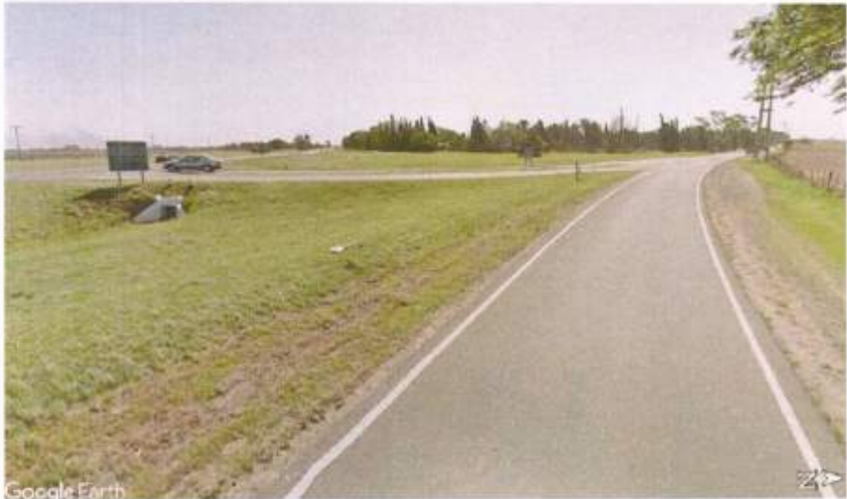
Figura 2.8 Vista de rama de salida de RN N°8 e ingreso a RN N°36 hacia el Oeste.
