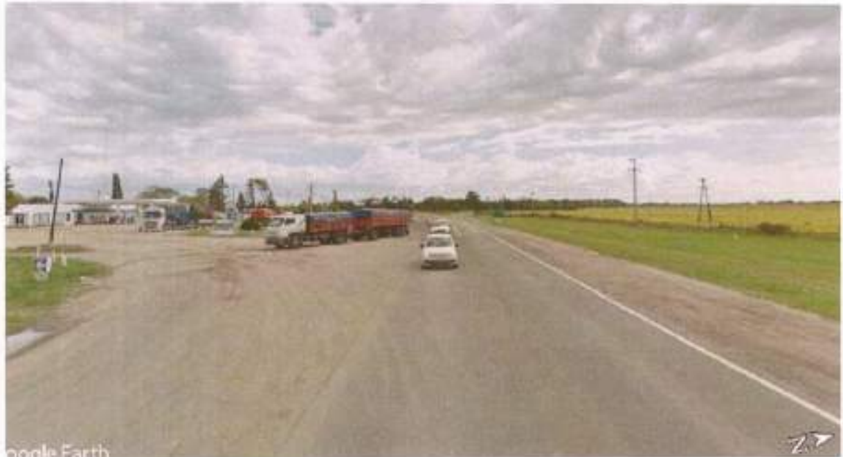
Figura 2.6 Vista de ingreso a estación de servicio lado descendente.
