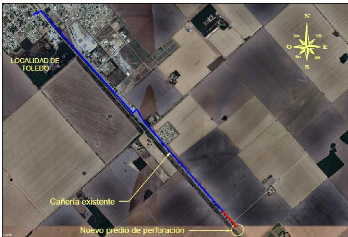
Figura N°3: Vista aérea localización de obra
