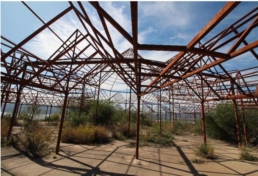
Foto n°12: "Interior de la estructura n°3"
