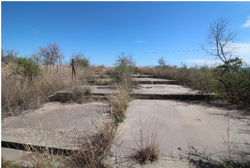
Foto n°10: "Escaleras de acceso a las estructuras"
