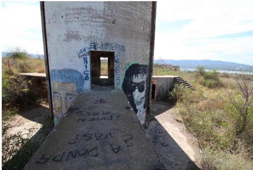
Foto n°6: "Entrada n°2 a la torre"
