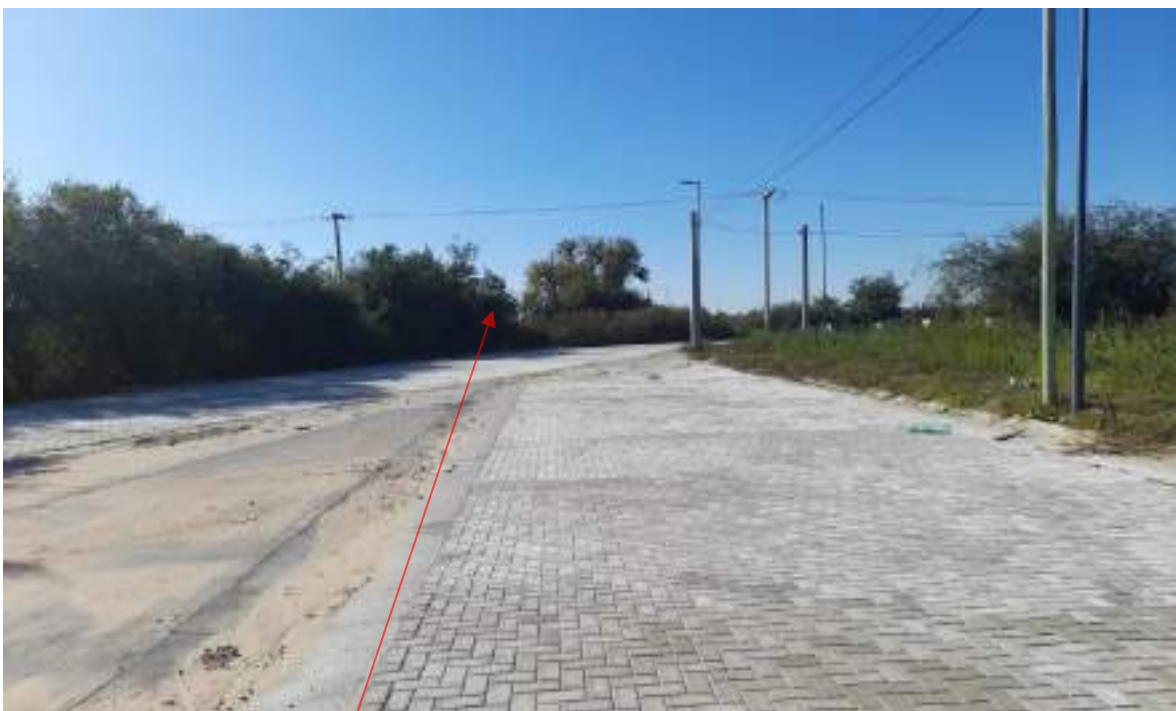
Vista del terreno en estudio.
