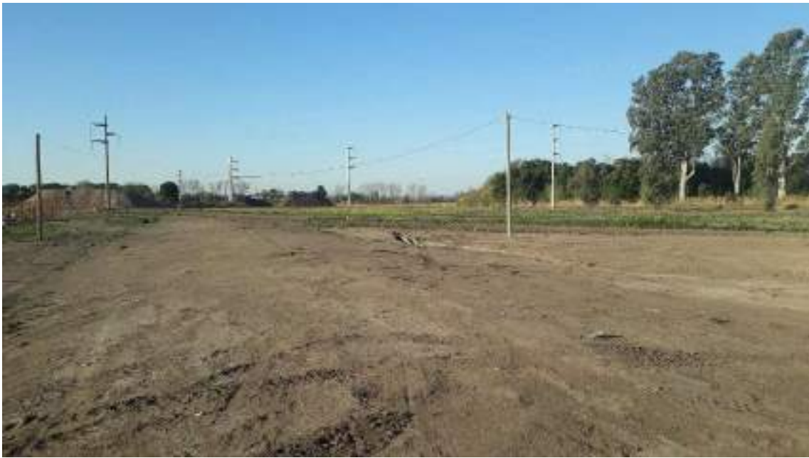
Fotografía n° 5. Apertura vial interna y postaje eléctrico de obra
