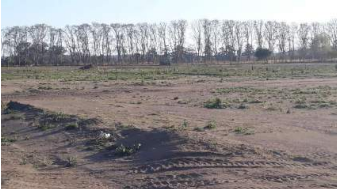
Fotografía n° 3. Estado de obras. Limpieza y nivelación.
