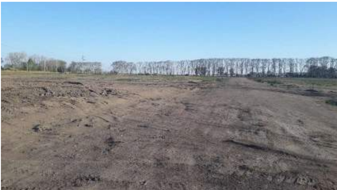
Fotografía n° 4. Limpieza, nivelación y marcación con apertura vial interna.
