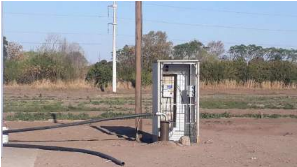
Fotografía n° 6. Perforación extractora de agua
