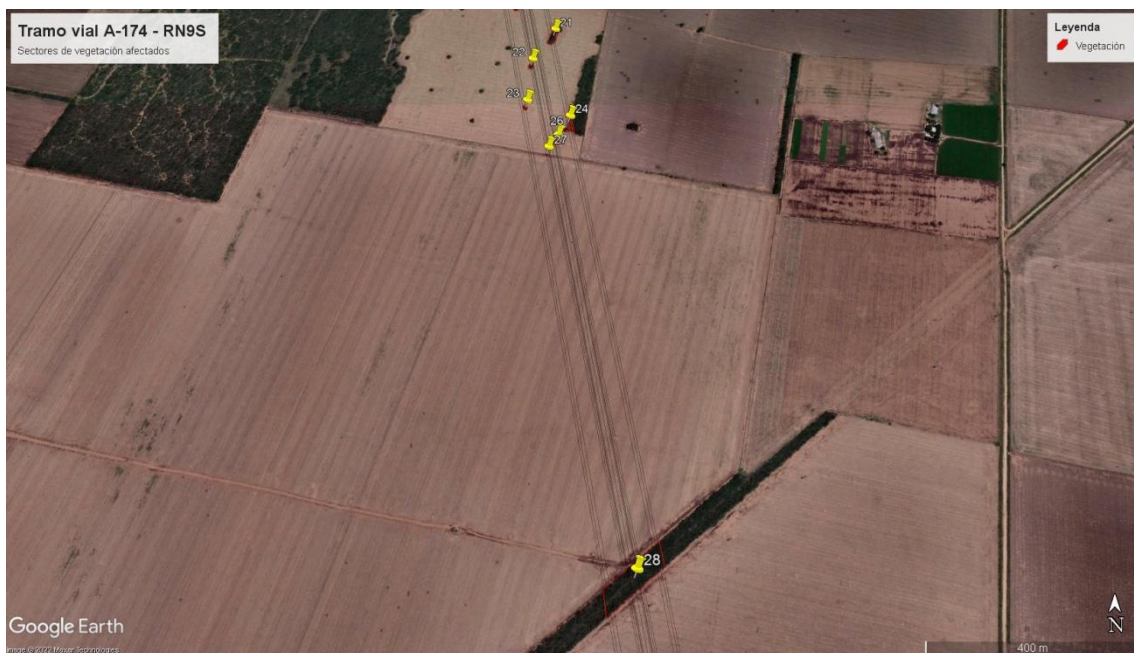
Sectores de vegetación afectados entre progresivas 16+000 y 19+500.
