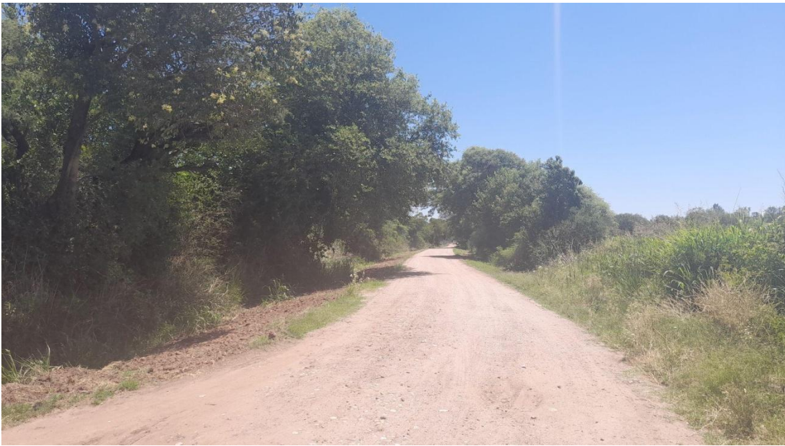
Vista de sector 1
