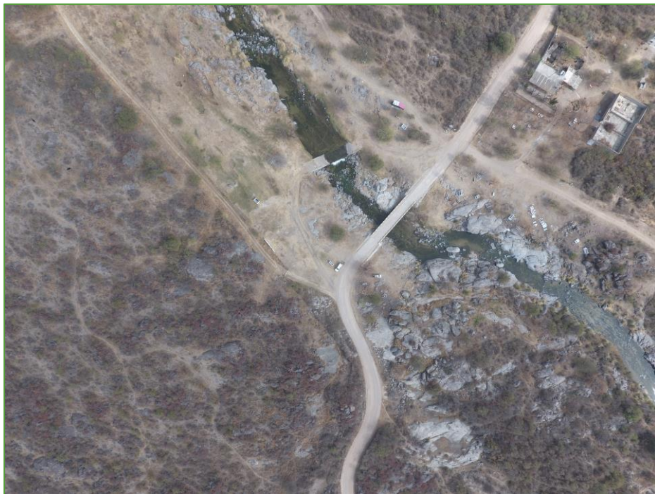
Puente del camino S-400 sobre el río Salsacate
