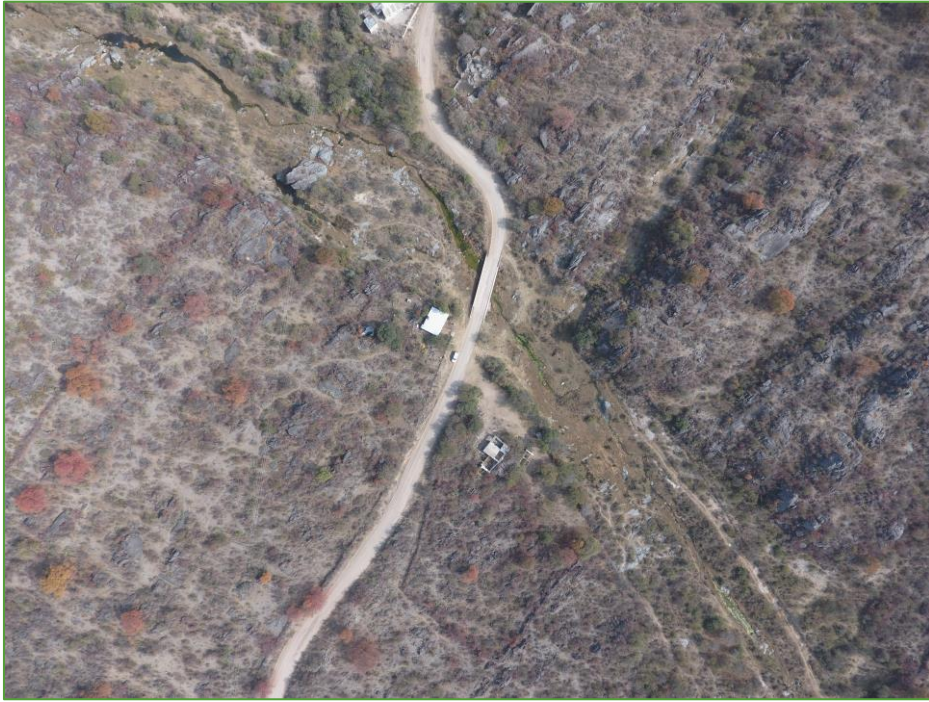
Vado del camino S-400 sobre el arroyo La Aguada
