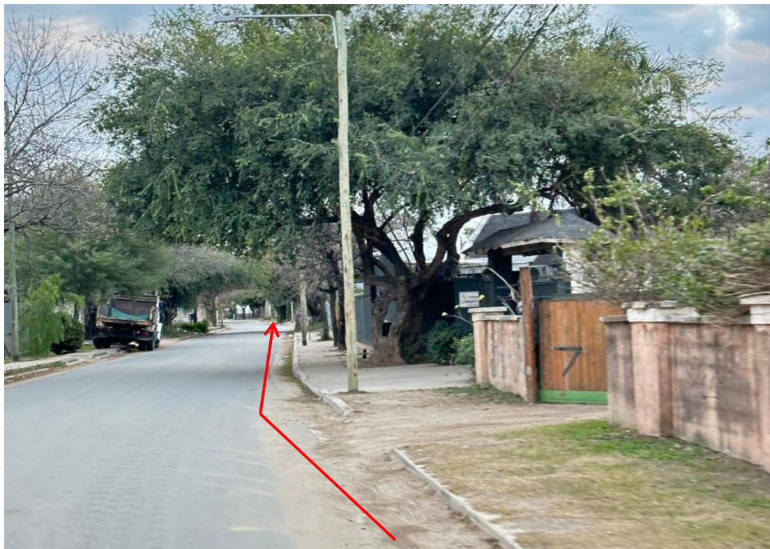
Imagen 10: Ramal de Alimentación en Calle Raymond Poincare
