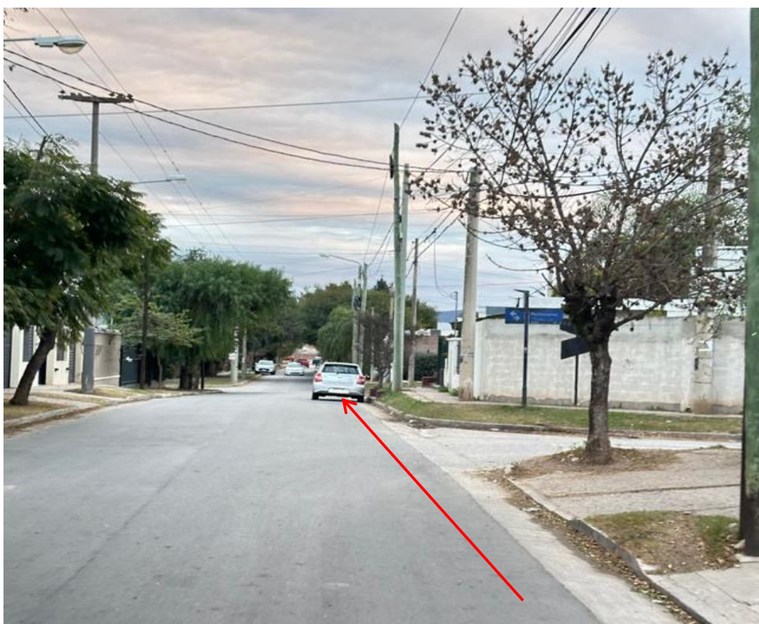
Imagen 9: Ramal de Alimentación en Calle Raymond Poincare
