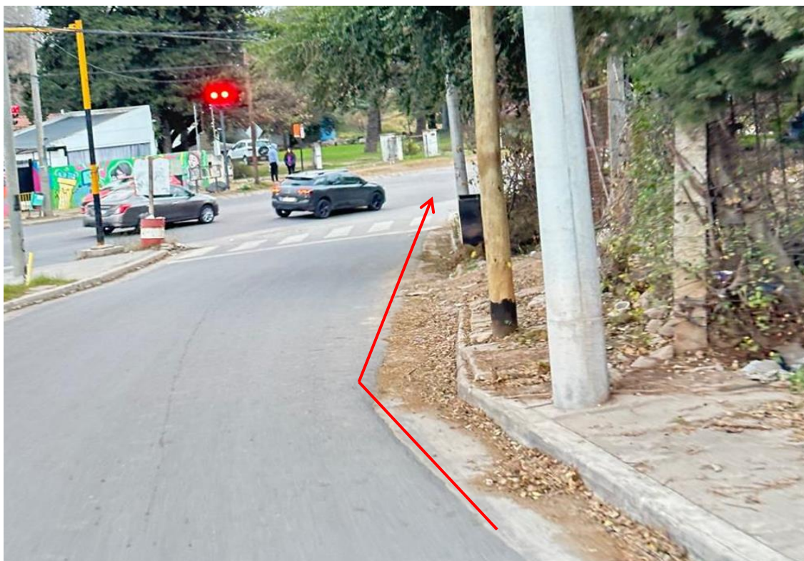
Imagen 12: Ramal de Alimentación en Calle Raymond Poincare
