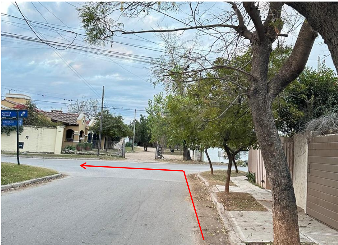
Imagen 5: Punto de Conexión a gasoducto existente Calle A. Sabin
