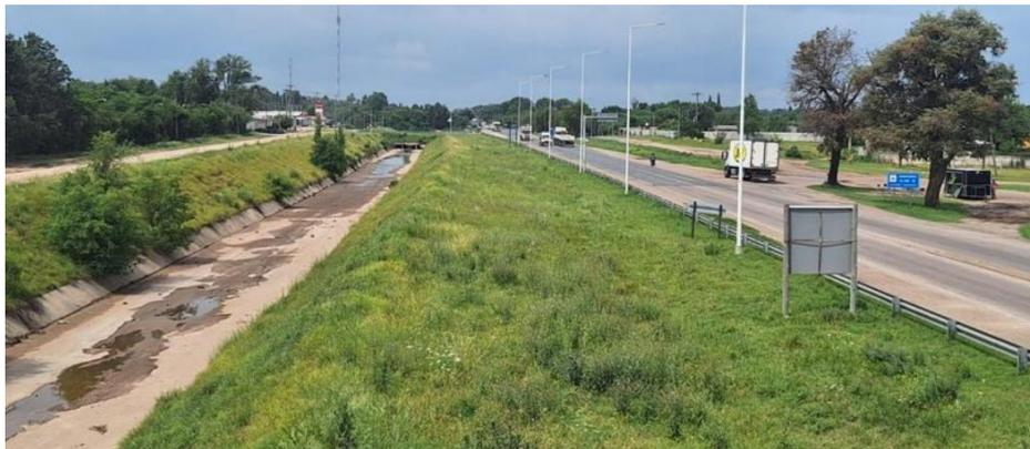
*Figura 7. Tramo duplicación, con canal revestido (imagen tomada del pliego de obra)*
