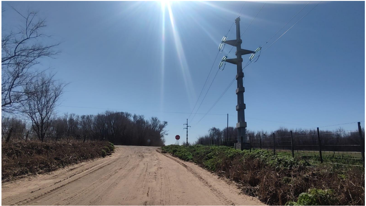
RP N10 en sector próximo a Intersección con RP11
