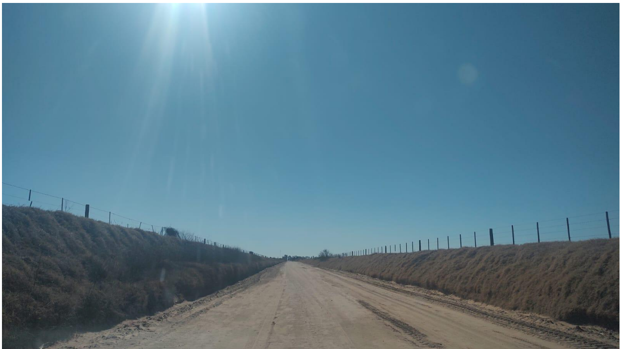
Tramo con rasante actual deprimida respecto a los campos colindantes
