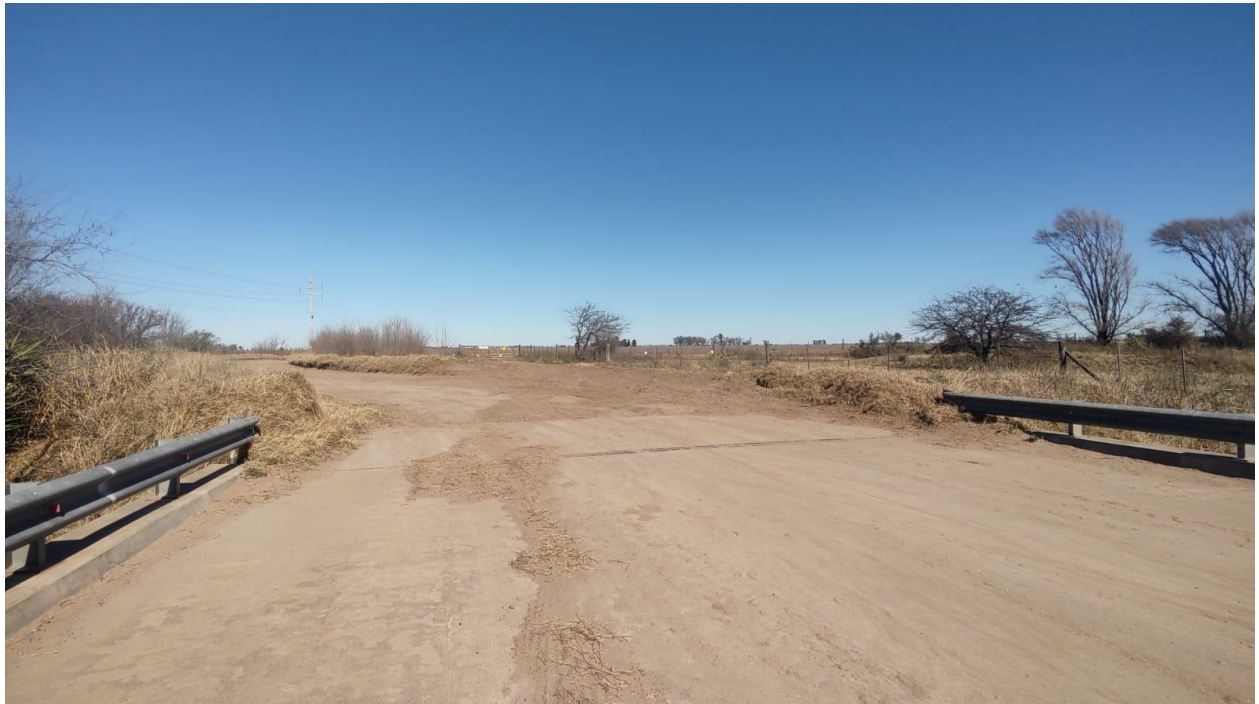
RP N10 en el cruce con el A° Carnerillo
