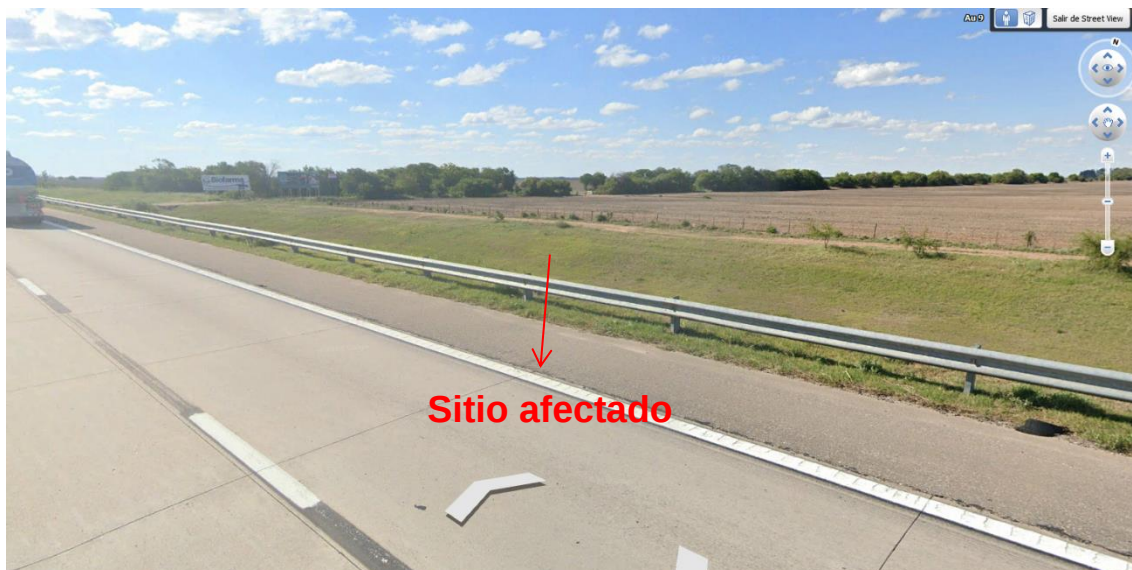
Imagen 3: Vista de la zona a tratar a nivel de la ruta
