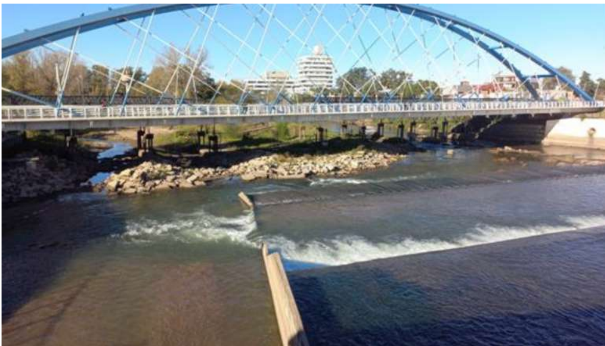
Figura 6: Puente Juan D. Perón y las obras de desvío para su reconstrucción.
