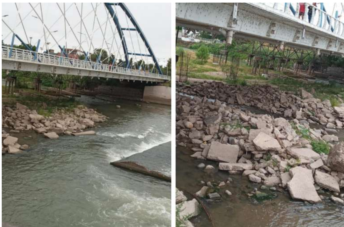
Figura 7: Puente Juan D. Perón y las obras de desvío para su reconstrucción.
