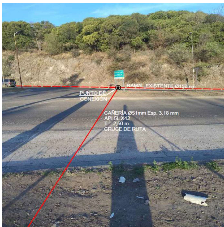
Imagen 10: Punto de Conexión a gasoducto existente
