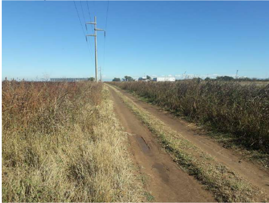
Imagen 4: Colectora Tierra del Fuego – Ruta Nacional N°19
